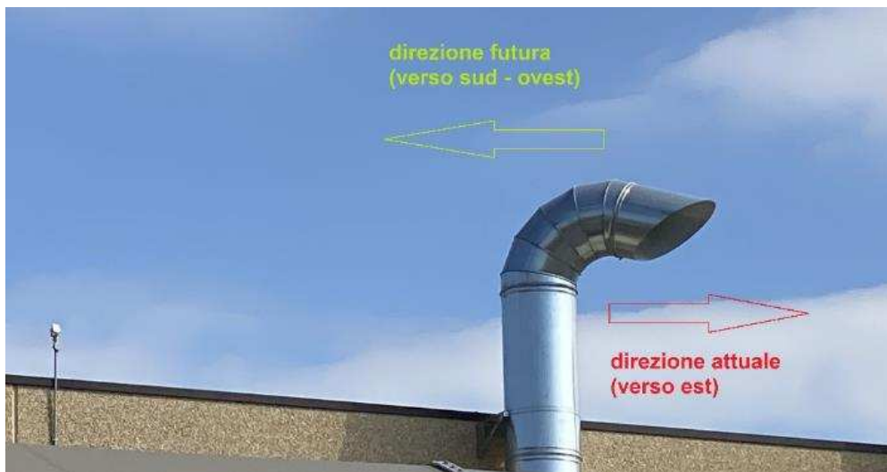
Emissione in atmosfera dell'attuale verniciatura (alla quale sarà affiancato il nuovo camino)
