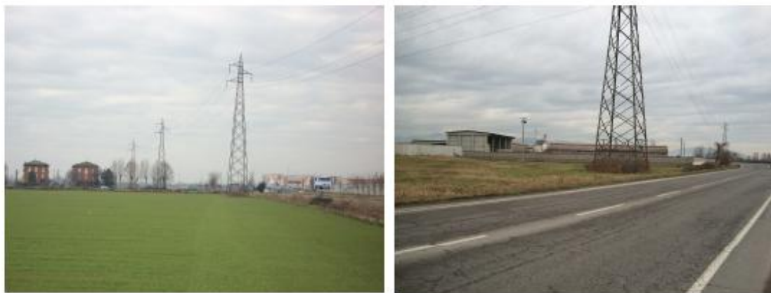
Sostegni per elettrodotti all'interno della zona oggetto di SUAP
