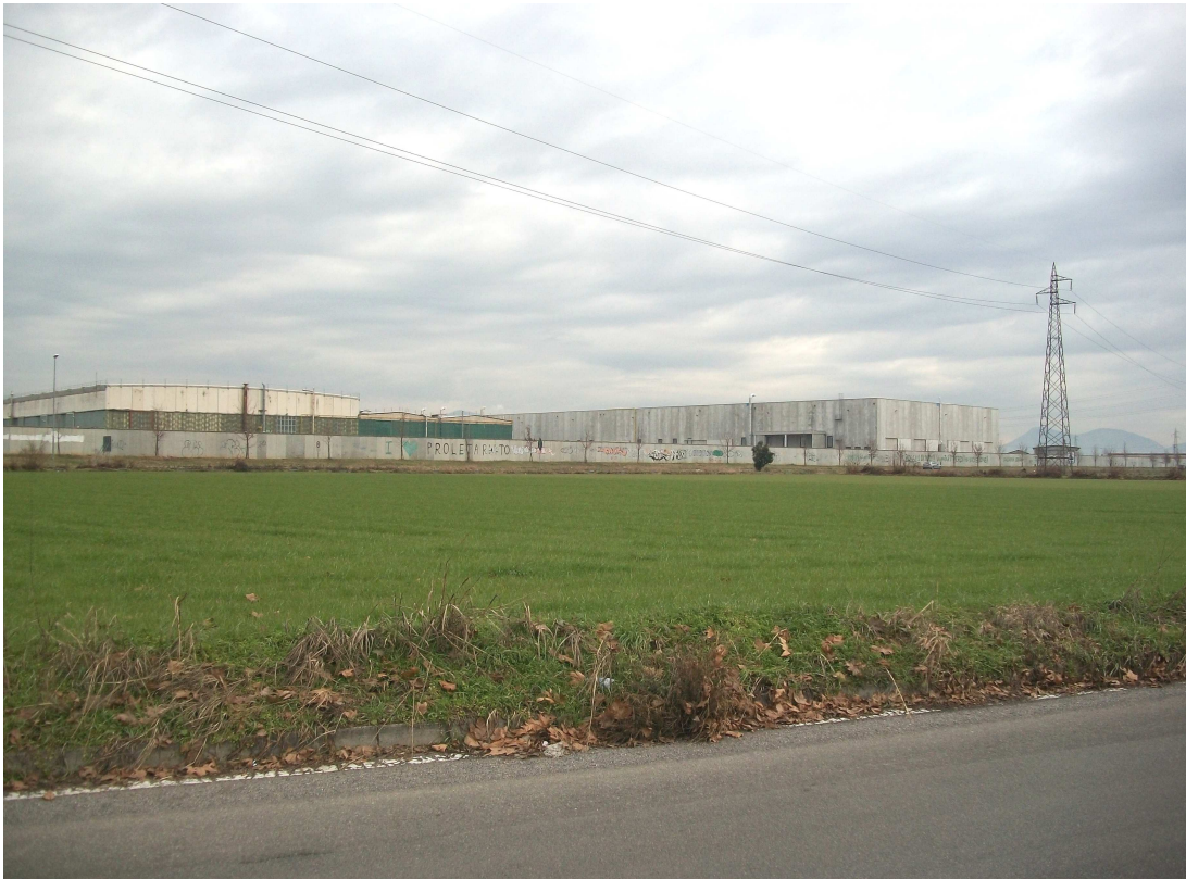
Lo stabilimento EURAL – Gnutti esistente e in primo piano la zona di ampliamento tramite SUAP
