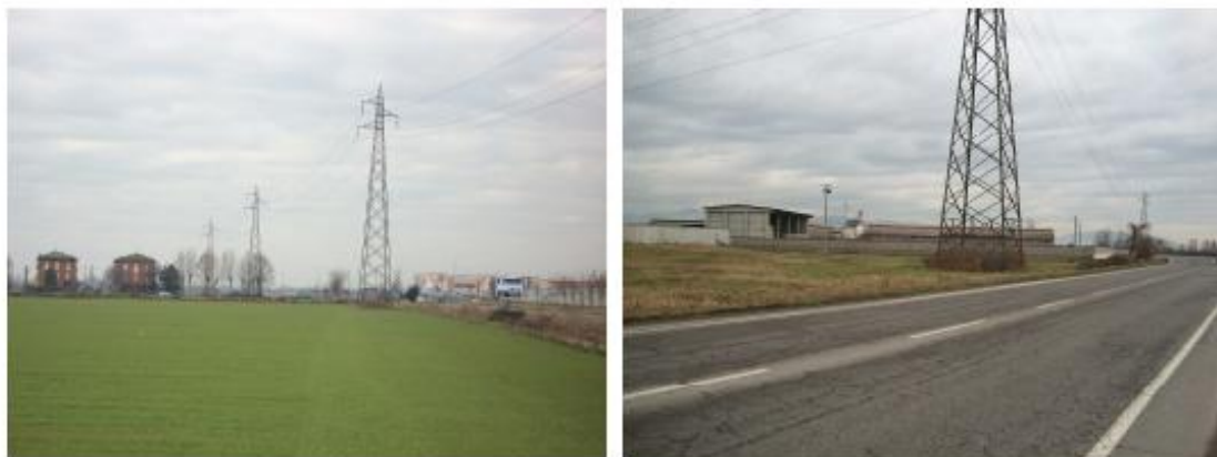
Sostegni per elettrodotti all'interno della zona oggetto di SUAP
