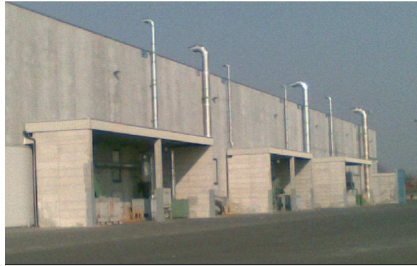
Un gruppo di impianti di aspirazione/filtrazione aria e da una torre di raffreddamento
