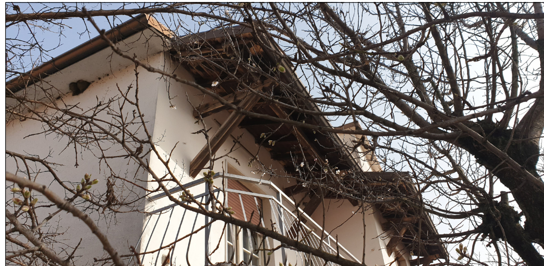
5) VISTA DEL BALCONE PIANO PRIMO E TETTOIETTA
