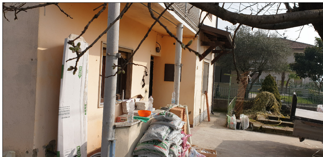
4) VISTA DEL PORTICO PIANO TERRA E CORTILE DI PROPRIETA'
