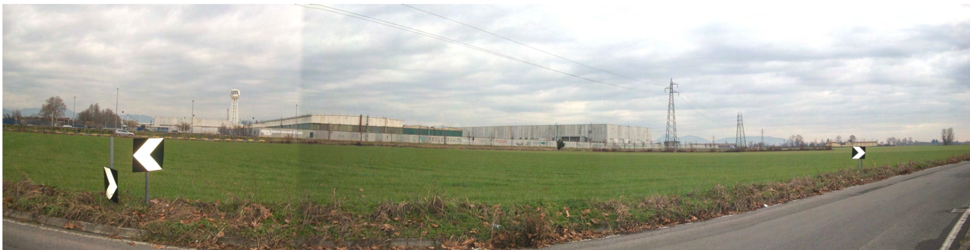
Veduta panoramica (sul fondo lo stabilimento esistente) – veduta da S. Andrea
