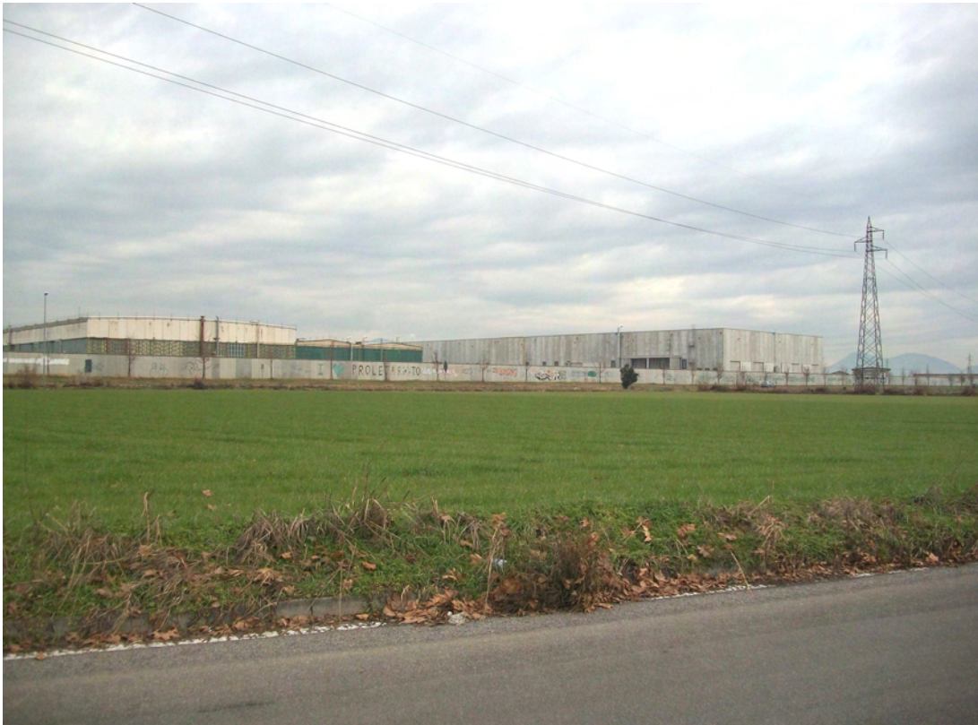
Lo stabilimento EURAL – Gnutti esistente e in primo piano la zona di ampliamento tramite SUAP
