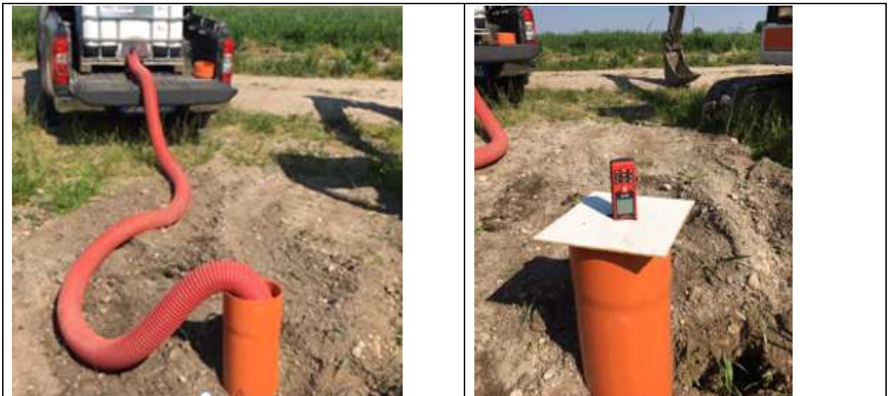
Figura 13 - Predisposizione del pozzetto di prova
