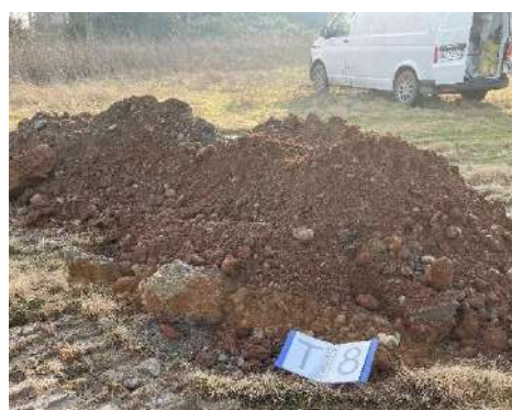
Foto n. 26: Cumulo 2 scavato da T.8
