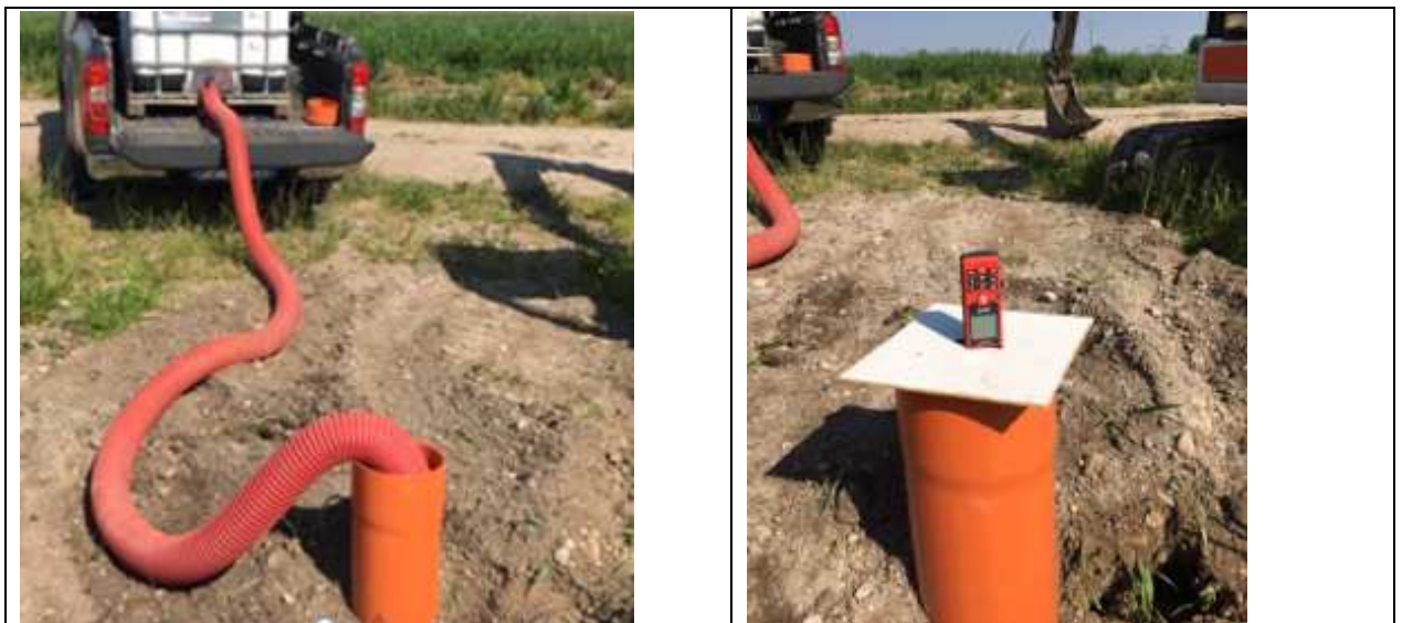
Figura 13 - Predisposizione del pozzetto di prova
