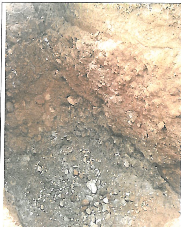
Fondo scavo e Pareti sud ed ovest
