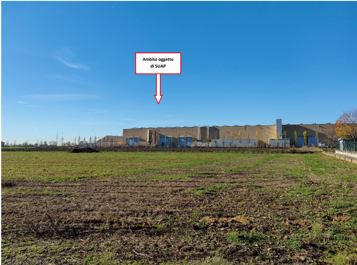
Vista da via S. Pellico da est a ovest - fotografia
